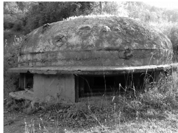
Figura 5. Búnquer que controla l'accés a la collada de Conflent. Disposa de la façana plana dels nius de metralladora, així com d'una cobertura parcial de pedres locals
