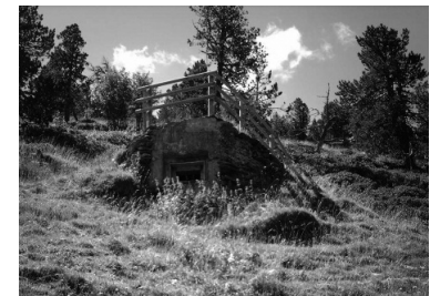
Figura 5. Búnquer que controla l'accés a la collada de Conflent. Disposa de la façana plana dels nius de metralladora, així com d'una cobertura parcial de pedres locals
